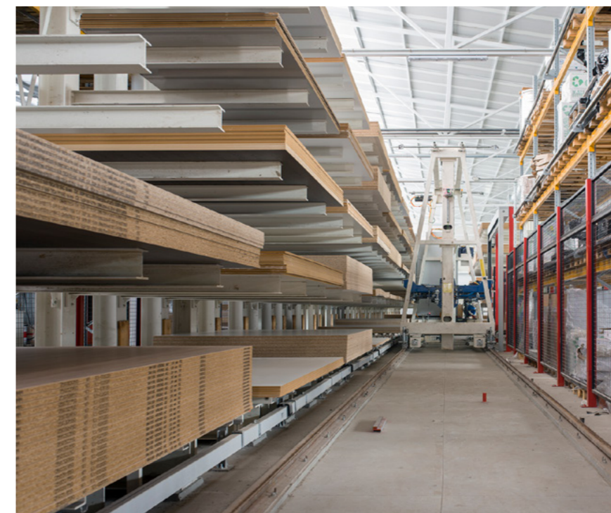
Stockage automatisé pour les panneaux.
