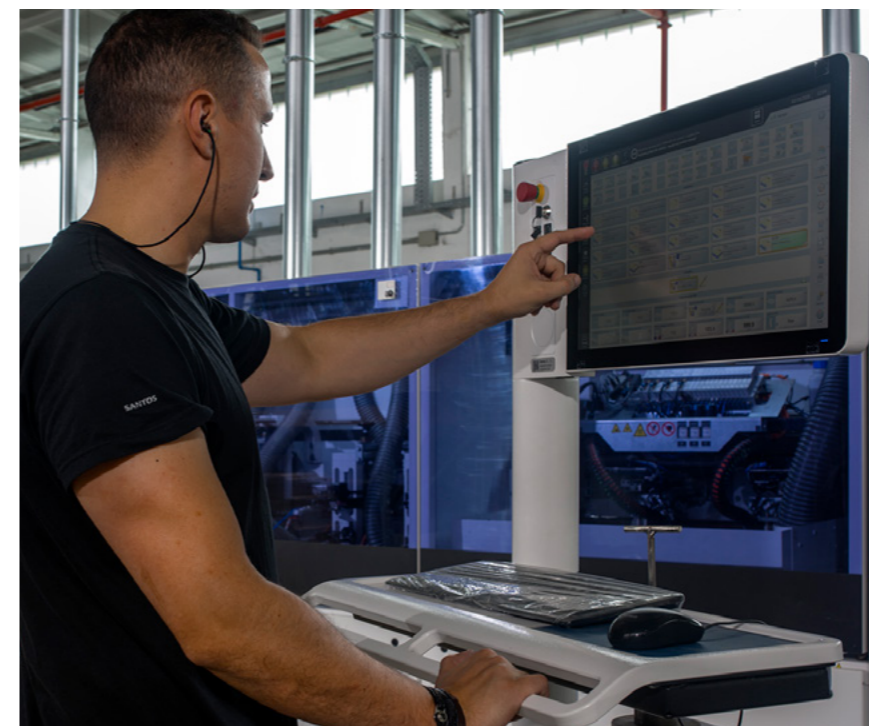
Paneles táctiles de control e información.
